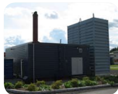
Oplandske Bioenergis flisfyrte bioanlegg Oplandske Bioenergis flisfyrte bioanlegg i Bagn leverer varme til kommunale brukere i Sør-Aurdal kommune.
