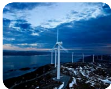
Hundhammerfjellet vindmøllepark Hundhammerfjellet vindmøllepark på Nærøy i Nord-Trøndelag består av 17 vindturbiner og er bygd ut i flere etapper siden 1998. Vindkraftverket har fungert som et teknologidemonstrasjonsanlegg for ny teknologi tilpasset norske forhold, og NTE fikk i 2009 støtte til en ny turbin som erstatter en tidligere testturbin.
