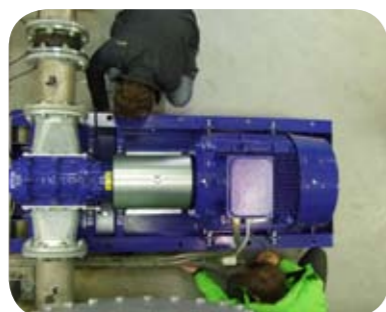
Energreen Energreen AS har fått støtte til å gjøre fullskala pilottesting av teknologi for å utvinne elektrisk energi fra trykkdifferanser i væske som strømmer i rør, typisk i vannverk.
